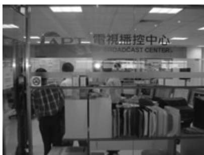
亚太卫星地面站播控机房
